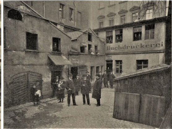
Innenhof Buchdruckerei vor dem Umbau
